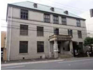
1914年，本野精吾によって設計された旧西陣織物館は，現在，京都市考古資料館として活用されている。
